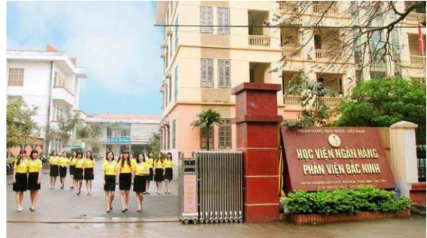
Hình 8: Học viện Ngân hàng, phân viện Bắc Ninh, thành phố Bắc Ninh
